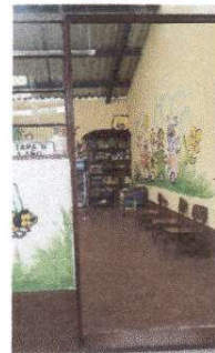
Foto 2: Sustitución de puerta de metal
